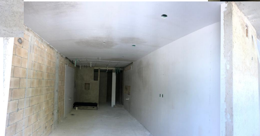
Trabajos de colocación de yeso en departamentos
