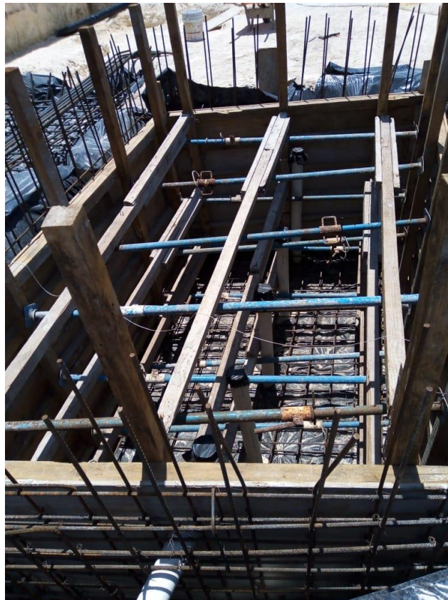
Trazo, perforación e hincado de pozos de absorción, excavación, colocación de plástico, acero y cimbra en cimentación de Torre B.
