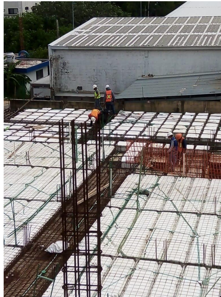
Nivel +4.40 (losa nervada y losa de vigueta y bovedilla) Colado de Concreto
