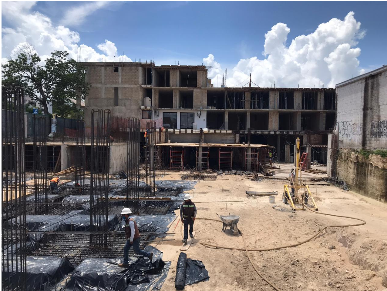
Avance general de la obra Julio-2020
