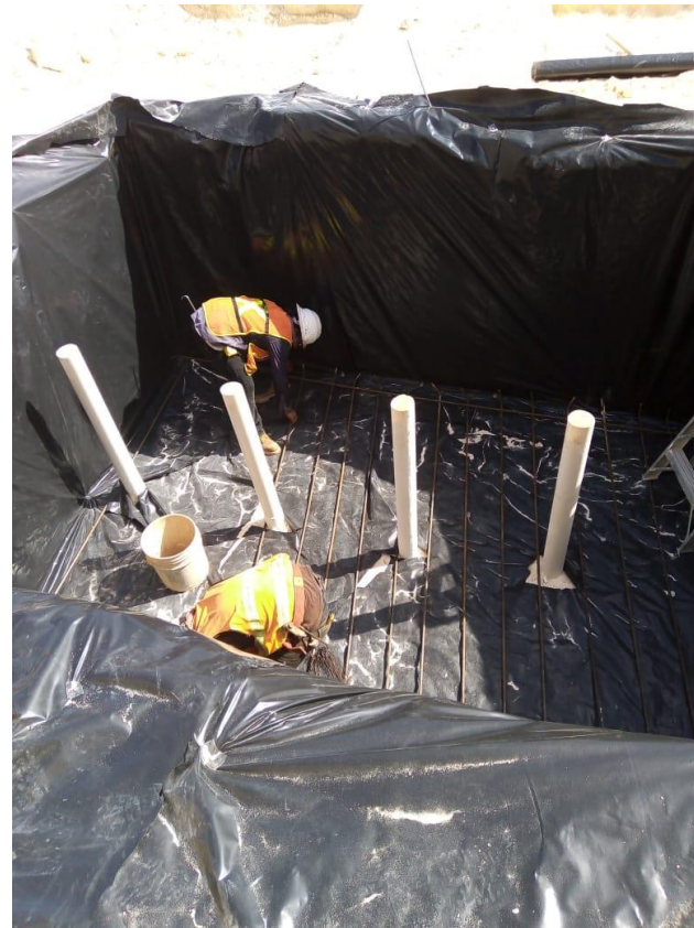
Trazo, perforación e hincado de pozos de absorción, excavación, colocación de plástico, acero y cimbra en cimentación de Torre B.
